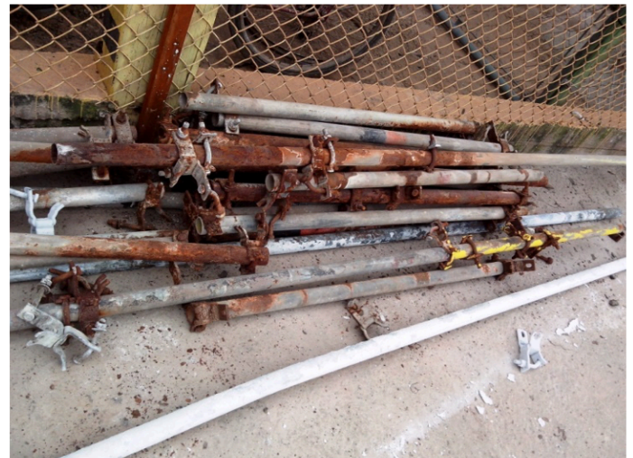
Figura 3: Materiais de andaimes descartados
