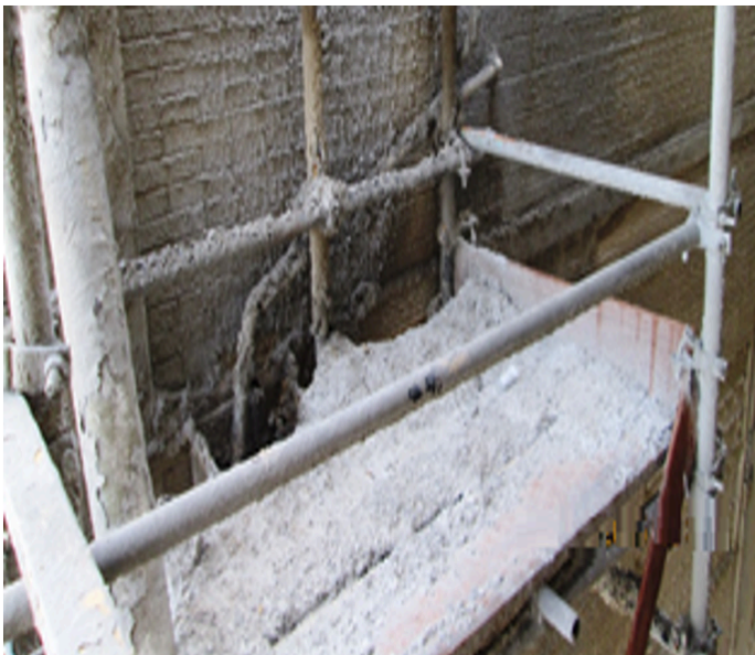
Figura 2: Andaime montado em área de ambiente severo
