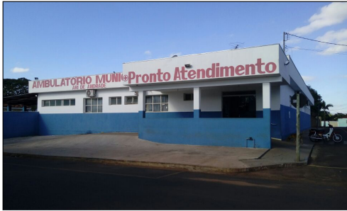
Figura 1: Fachada Principal do Ambulatório Municipal Ari de Andrade
