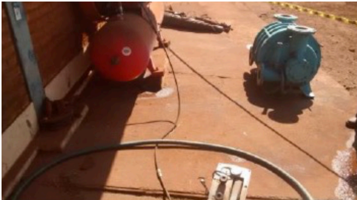
Figura 4: Execução do teste hidrostático
