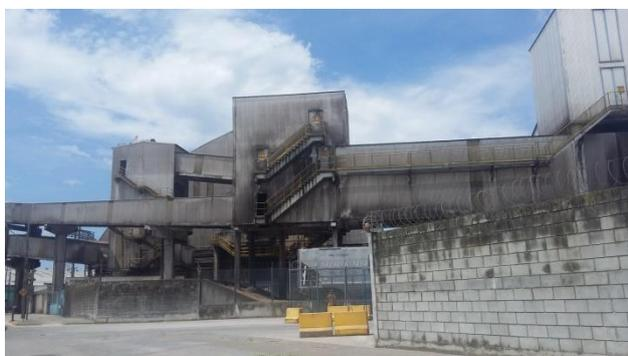
**Figura 7:** Instalação de esteiras transportadoras no COREX
